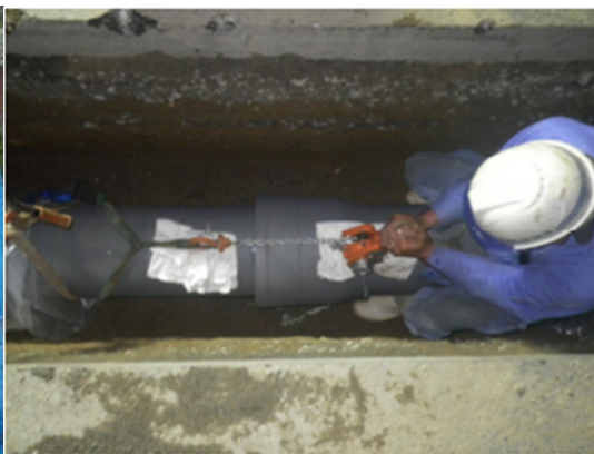
【岡山市瀬戸町線送水管（GX 耐震管）】
