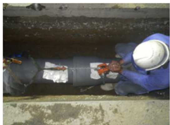
【岡山市瀬戸町線送水管 (GX耐震管)】
