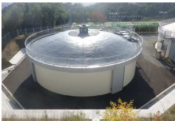
【総社第2調整池 左側増設 右側既設】
